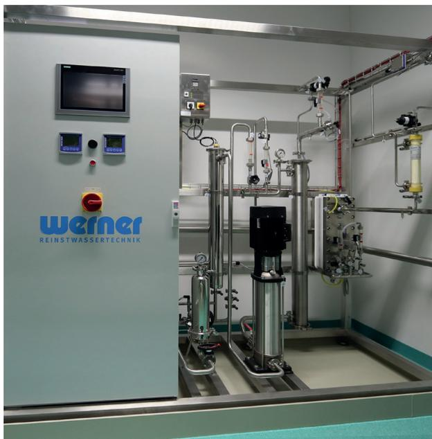
Abbildung 6: Membranbasierte, kalte WFI Erzeugeranlage 100 l/h (Quelle: Werner GmbH).
