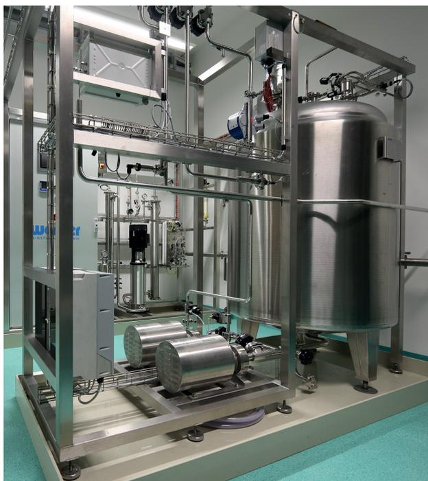
Abbildung 7: WFI-Lager- und -Verteilssystem 80 °C (Quelle: Werner GmbH).
